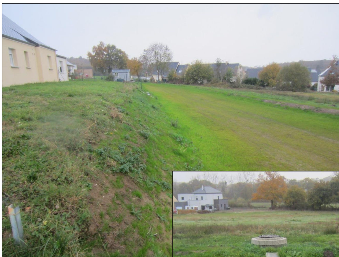
Photo 1 : Vue du bassin d'orage et de l'ouvrage de sortie du lotissement « Le Domaine de Lozier »
