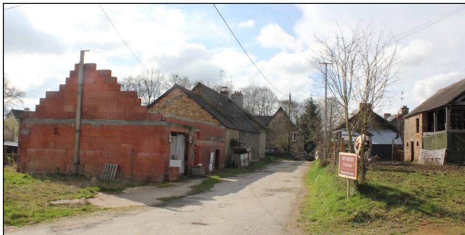
Extension neuve dans le tissu ancien du hameau de La Gâterie.
