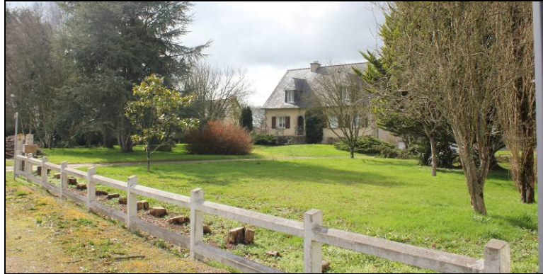
Exemple d'habitat diffus de MÉZIÈRES-SUR-COUESNON.
