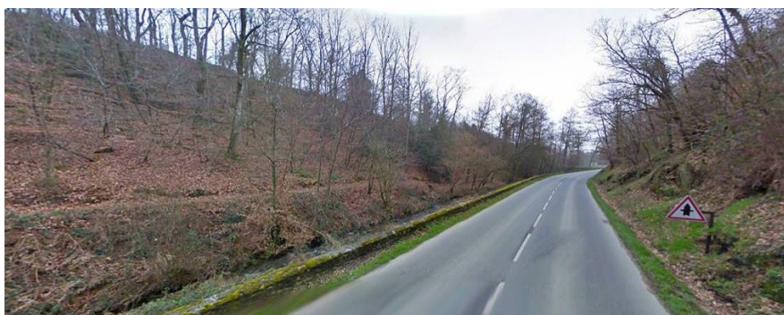
Ruisseau de la Motte le long de la RD 102
