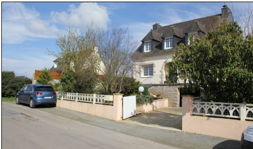
Exemple de maison individuelle, des années 1960/1970, sur rez-de-chaussée technique.
