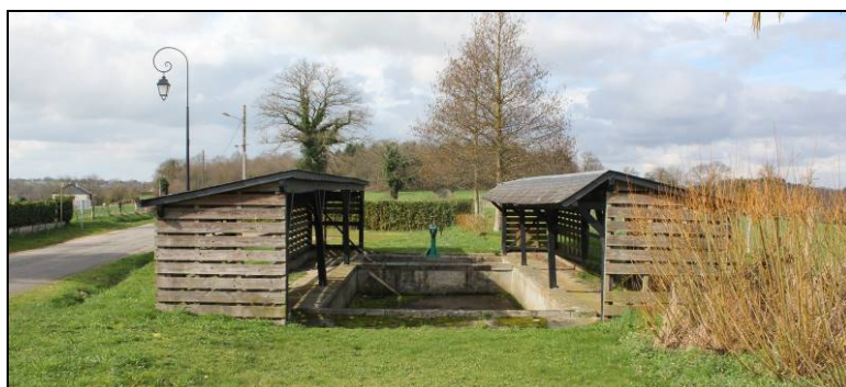
Le lavoir en entrée de bourg.
