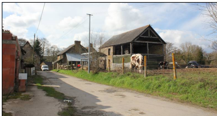
Bâtiments agricoles en cœur de hameau : les bâtiments reprennent l'orientation des bâtiments d'habitation.
