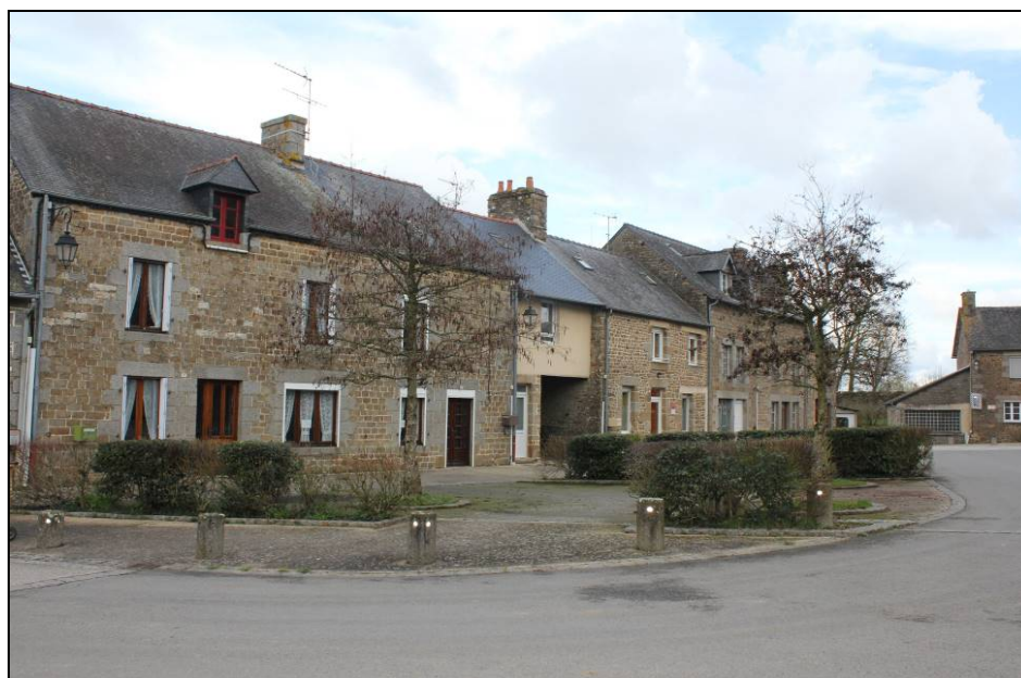
Place de l'église : les maisons sont mitoyennes et développent des jardins sur l'arrière de la place. Les variations d'épannelage (hauteur des toitures) animent le front urbain constitué.
