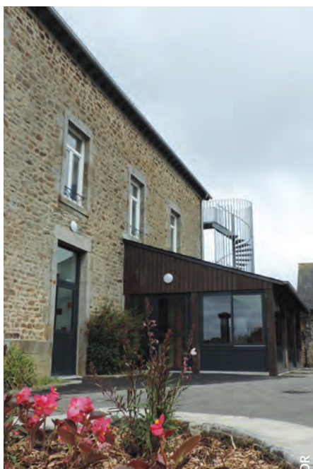
L'ancienne base de loisirs a été rénovée.
